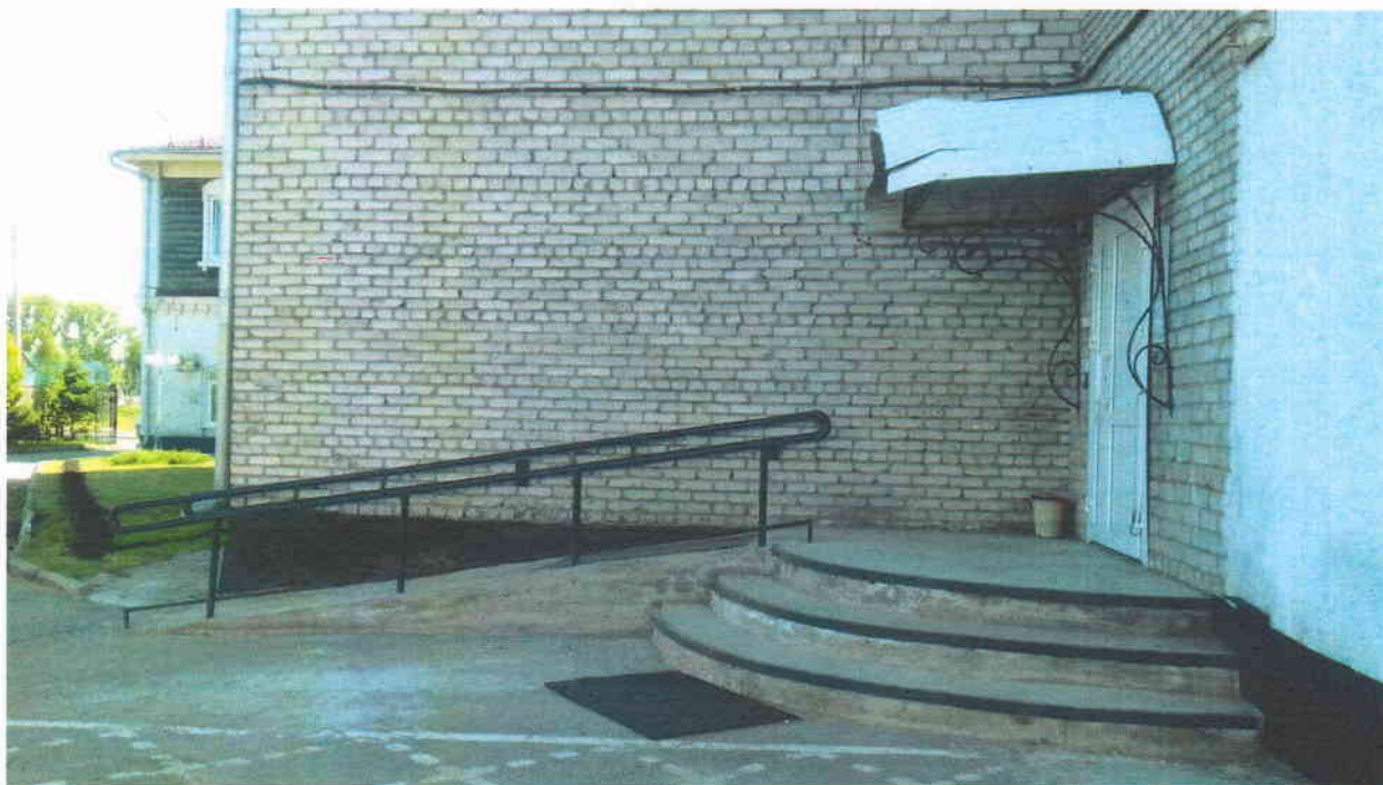
Фото 7. Лестница (наружная) Дверь (входная). Пандус (наружная).
